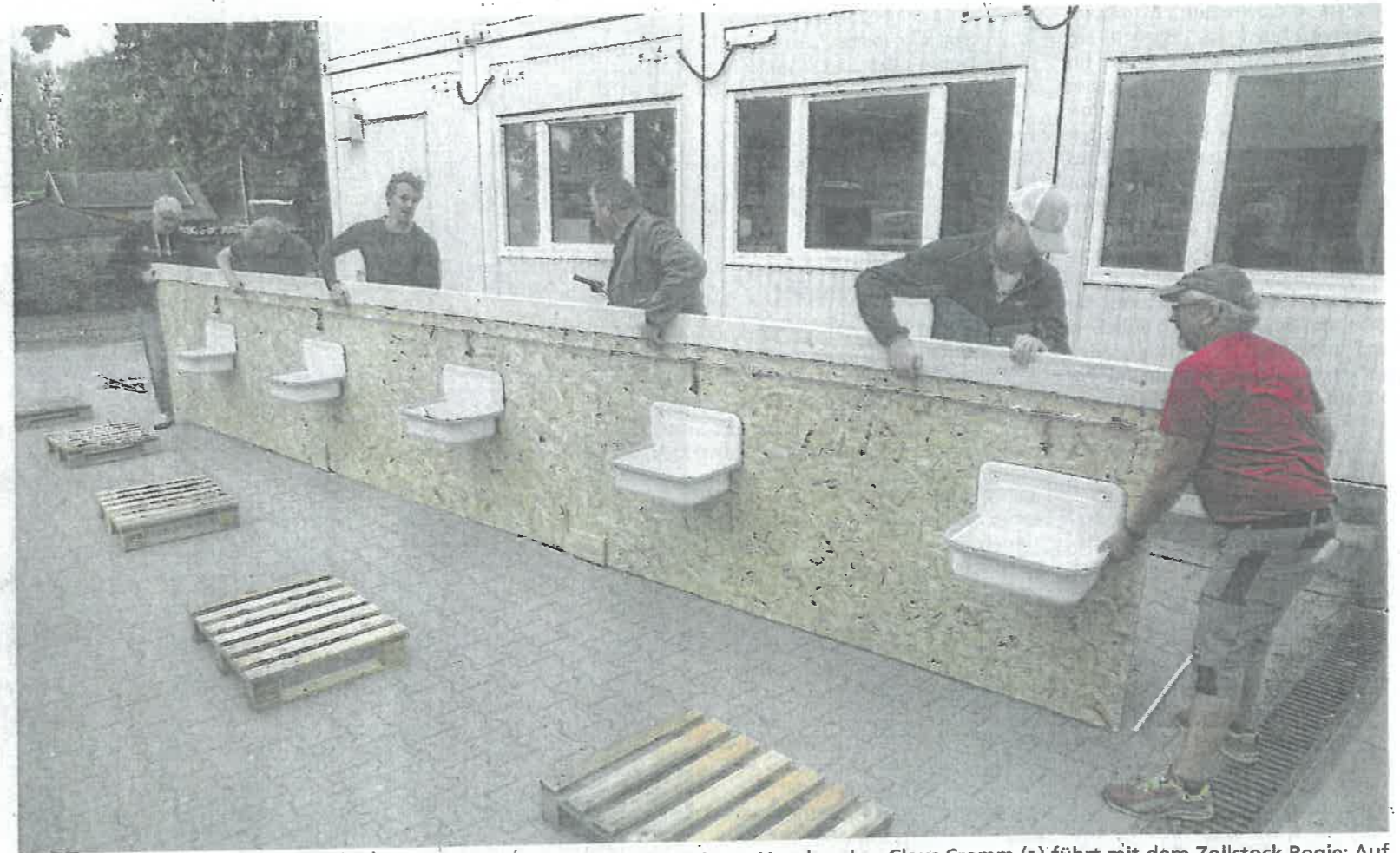
Die Schulleiter Ulrich Grünenwald und Jens Volcksdorff (v.l.) packen mit an, Handwerker Claus Cromm (r.) führt mit dem Zollstock Regie: Auf beide Seiten der Grobspanplatten kommen – jeweils versetzt – Handwaschbecken für die Schüler des Container-Provisoriums. FOTO: MAIK REUSS
